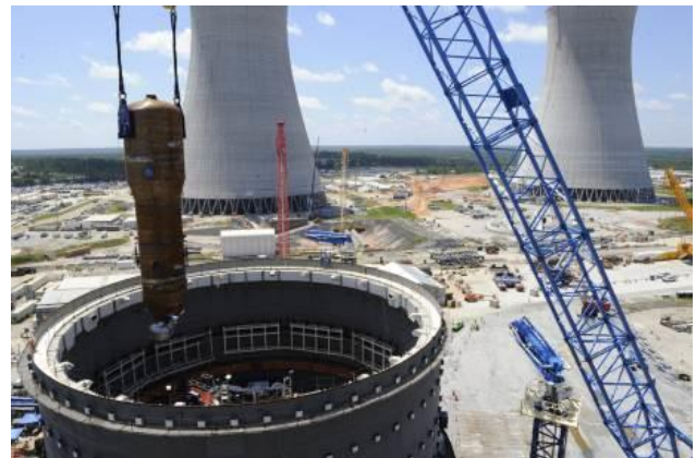
Montáž PG na bloku Vogtle-3
