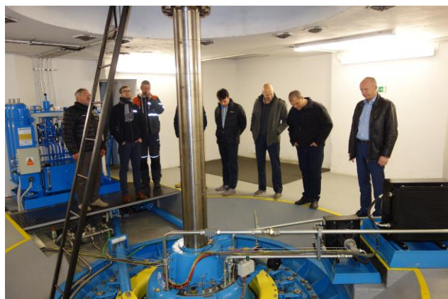
V strojovni vodnej elektrárne Kníničky
