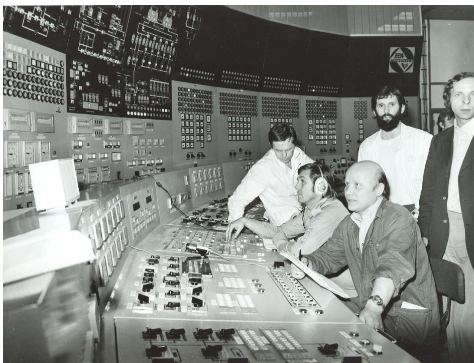
Na blokovej dozorni V1
