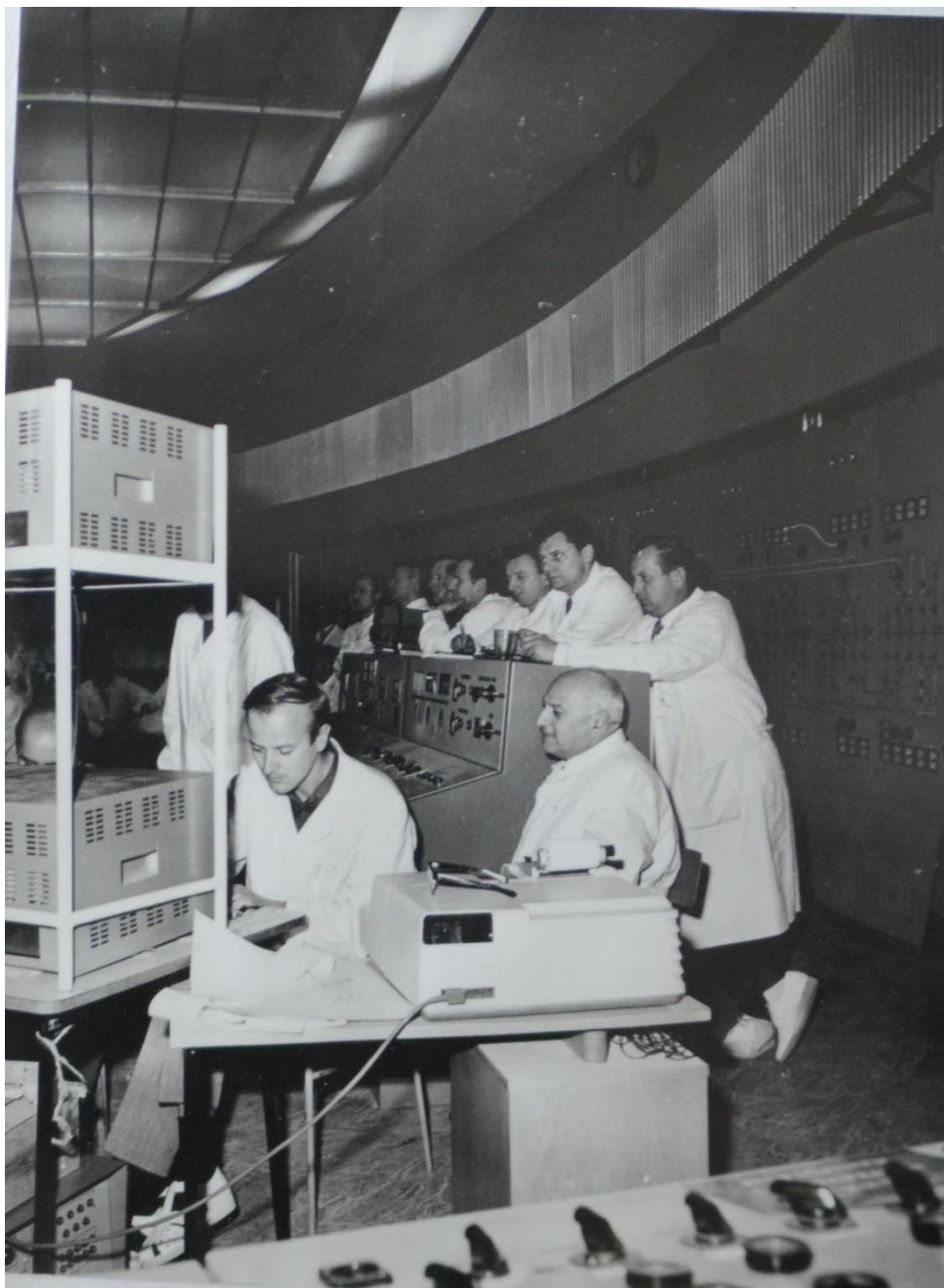
Nočná zmena z 23. na 24.10.1972 – výpočet \Delta h do dosiahnutia kritickej úrovne ťažkej vody v reaktore JE A1 (na prvom stolovom „minipočítači“ s kapacitou – 10 premenných, 100 programovacích krokov)
