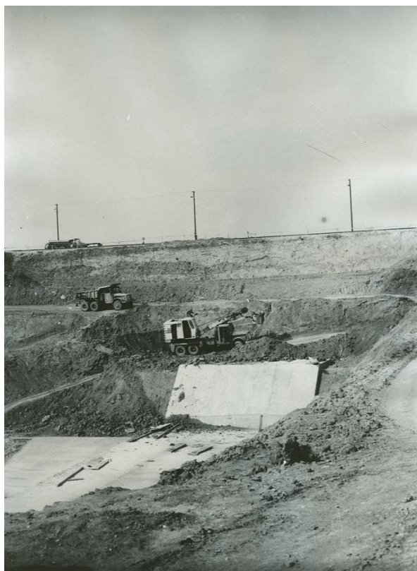
Výkop hlavného výrobného bloku V1, r. 1973
