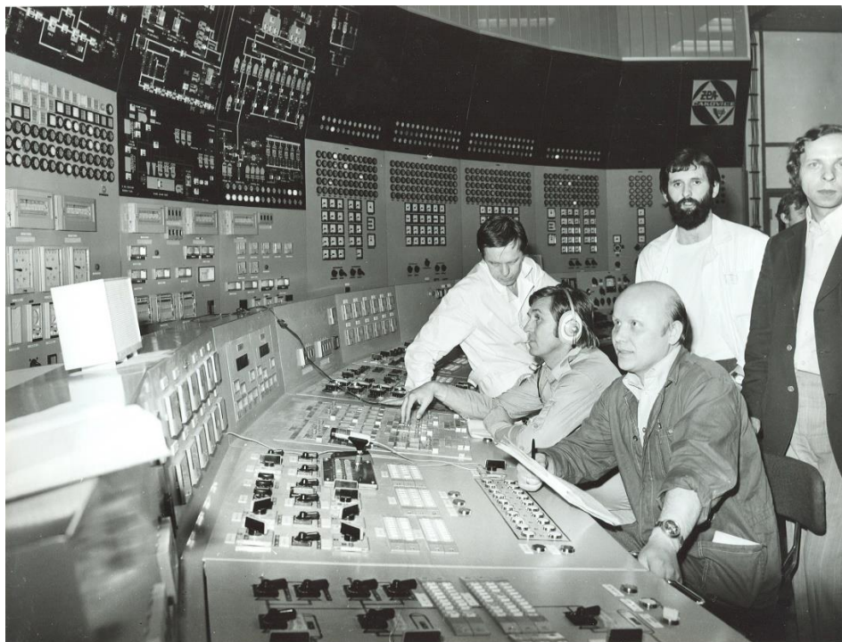
Na blokovej dozorni V1
