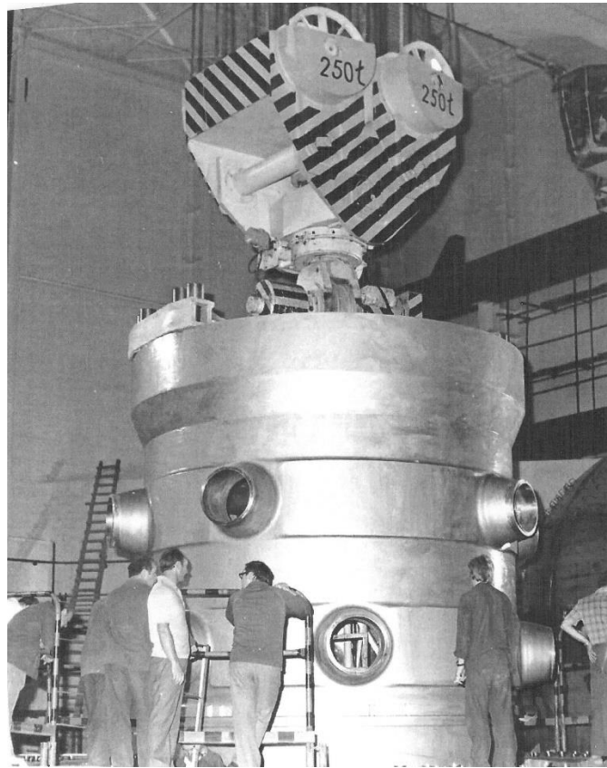
Montáž tlakovej nádoby reaktora V1
