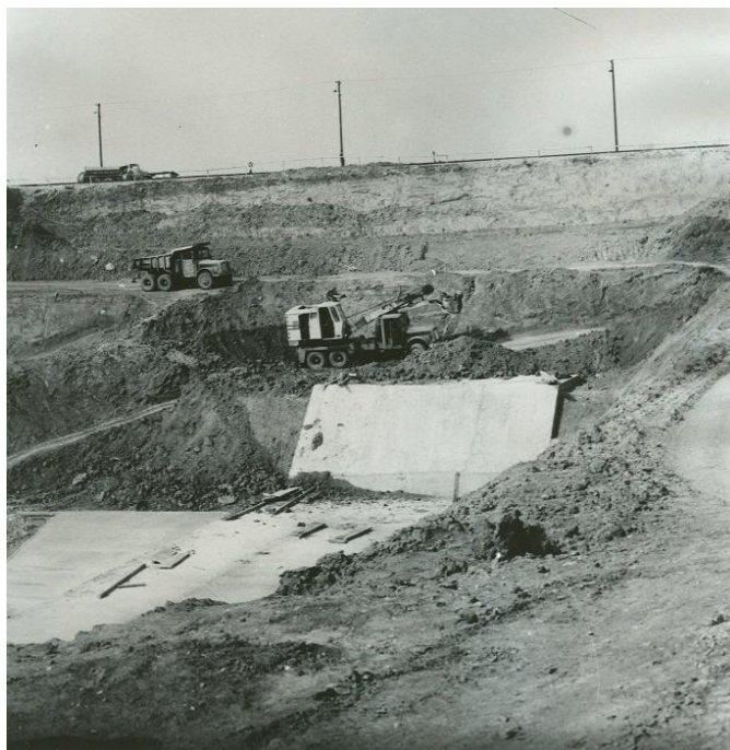
Výkop hlavného výrobného bloku V1, r. 1973
