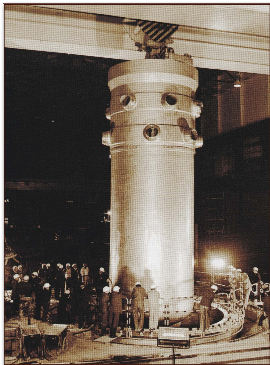
Tlaková nádoba nad šachtou reaktora, Jaslovské Bohunice
