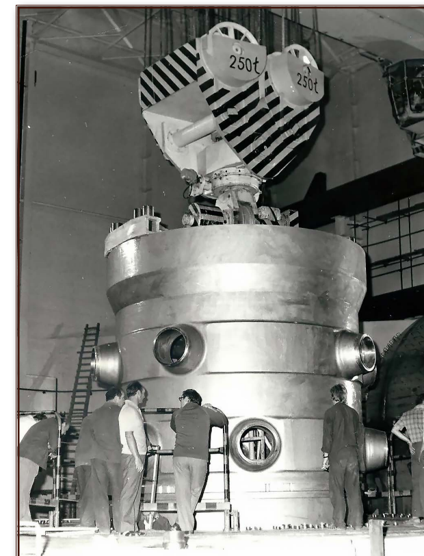
Montáž tlakovej nádoby reaktora V1
